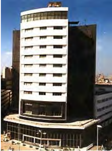
شكل رقم (١٤-٥) مبنى جريدة الأهرام الذي صممه ناعوم شبيب عام ١٩٦٠ المصدر : http://www.archnet.com
