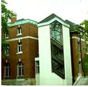
شكل رقم (٥-٣) سلم مضاف لمبنى قائم وفيه يظهر مدى التعارض مع الهوية القائمة.
