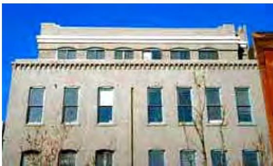
شكل رقم (٥-٥) يظهر الجزء العلوي المضاف لسطح هذا المبنى وكأنه جزء من المبنى التاريخي القديم لأنه يحاكي نفس التصميم من حيث الشكل واللون والنوافذ.
