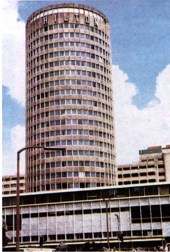
شكل رقم (٢٣-١) الشكل المركزي لمبنى فندق هيلتون - نيروبي المصدر : صلاح زيتون، عمارة القرن العشرين
