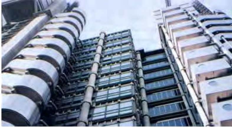
شكل رقم (١-٤٣) استخدام الألومنيوم كمادة إنشاء وتشطيب بينك لويدز ، لندن المصدر : صلاح زيتون - عمارة القرن العشرين
